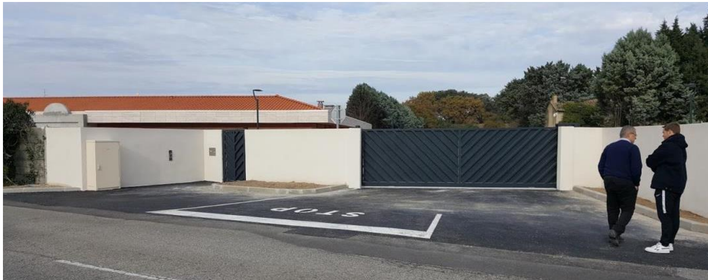
Entrée du séminaire diocésain missionnaire Redemptoris Mater d'Avignon, vue depuis l'avenue Jules Vernes – SORGUES
