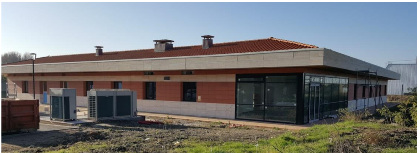
Fachada oeste do seminário e as portas de vidro do refeitório.
