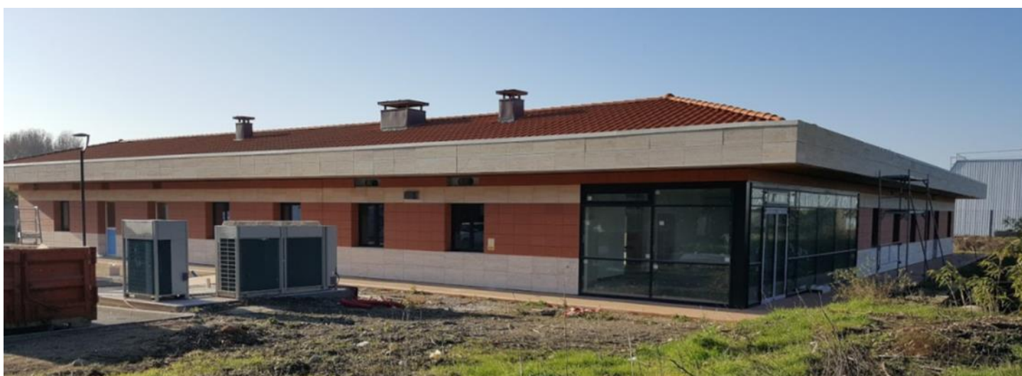
Fachada oeste del seminario y las vidrieras del comedor.
