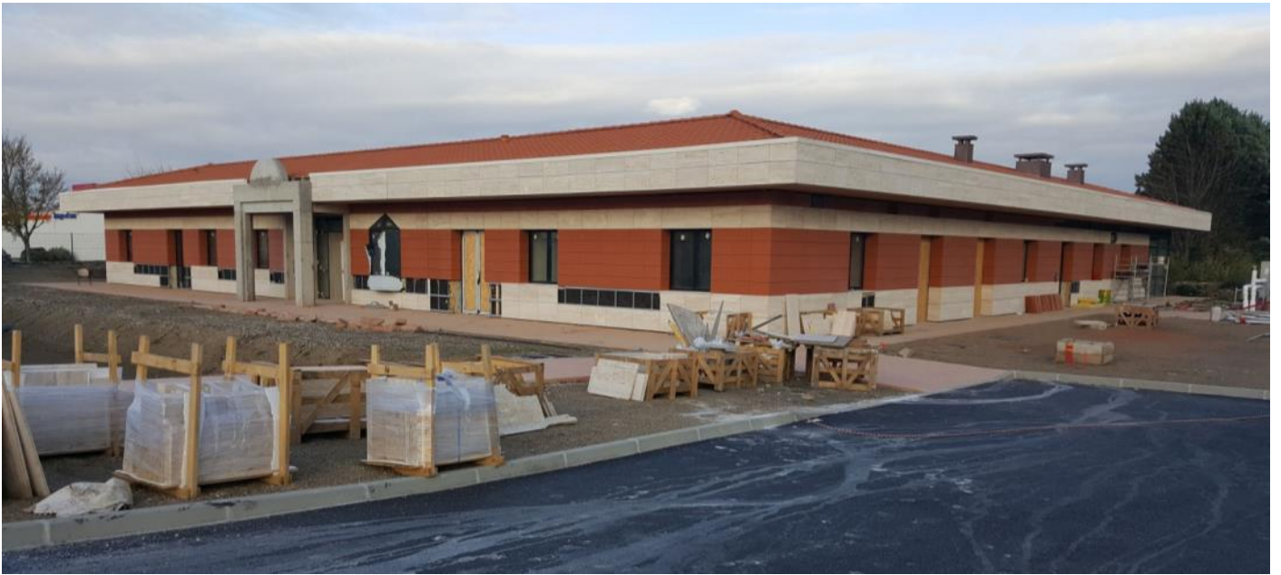
Vista da fachada sudeste do seminário e as obras de desenvolvimento dos espaços ao redor do edifício.
